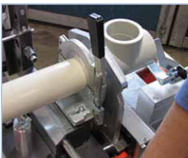
Lim sammen rør og muff.
