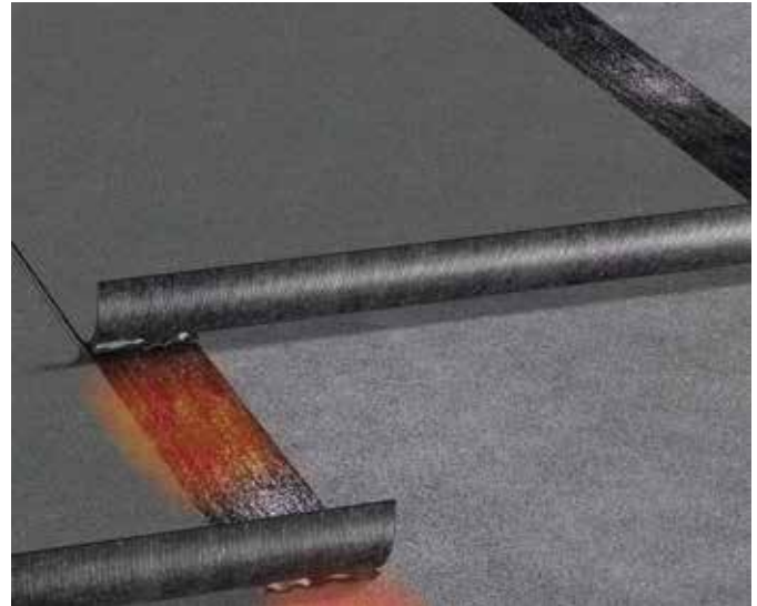
Omtekking på gammelt asfalt takbelegg.
