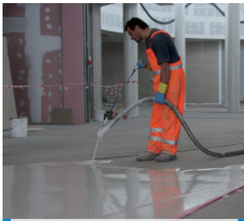
Mekanisk påføring av Ultratop N
