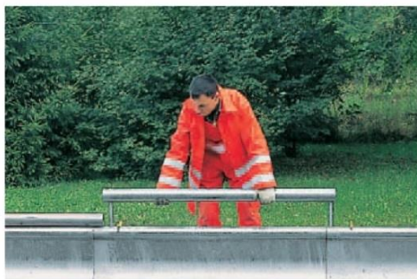
Figur 2: Montering til midtelement med koblingsrør
