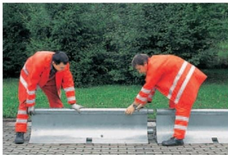
Figur 1: Montering til startelement
