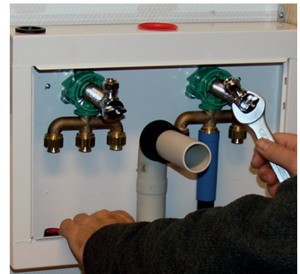
15. Tilpass og monter vinkelventiler i veggbokser. Plugg ubenyttede uttak.
