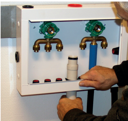
13. Klargjør og koble til rør for vannkurser og avløp. Plugg ubenyttede uttak.
