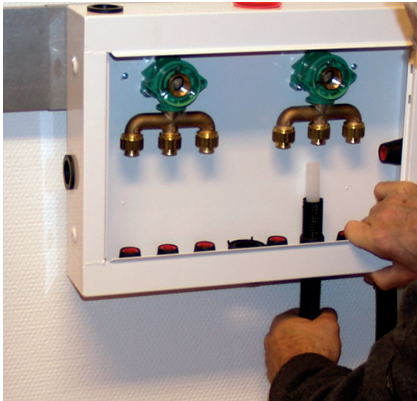
10. Skyv rørene inn i skapet gjennom aktuelle gjennomføringer.
