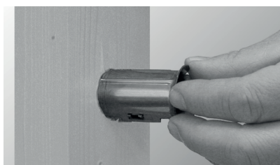
Skyv spikeravviseren inn i stender med kragen mot tappestedet.
