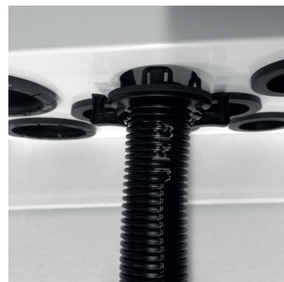
3. Monter klipset igjennom ett av hullene i bunnen av skapet.
