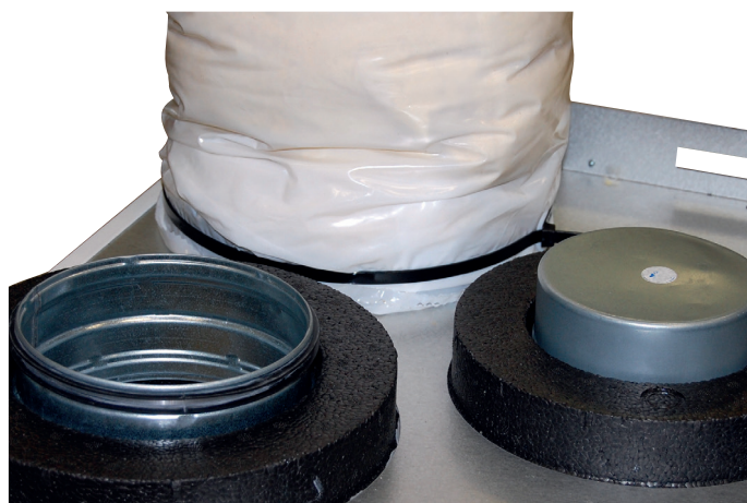
Figur 21 Ferdig montert kanal
