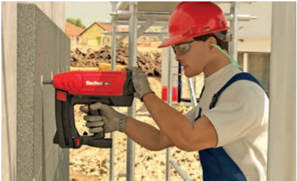
Den spesielle E-Fix-nesen til FGC 100 gjør det mulig å feste isolasjonsmaterialer.
