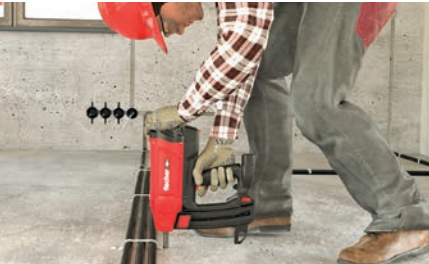
For å feste elektriske tilførsler, f.eks. ledninger, rør og elektriske kabler, til gulv, vegg eller tak.
