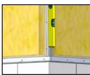
7) Skru fast del 1 av den innvendige hjørnelisten. Hvis hjørnet ikke er i lodd må platen tilpasses avviket. Kapp platen slik at utflesingen kommer på baksiden av platen. Hvis platen er for lang, kapp alltid overskytende lengde fra toppen av platen både for å ivareta dryppnesen i bunnen, samt for å ivareta flisemønster.
