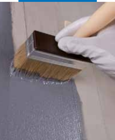
Påføring av Eco Prim Grip på betong med børste
