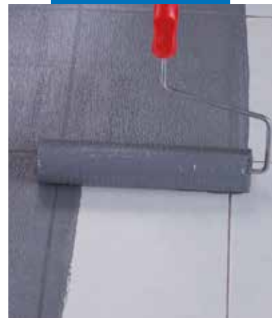
Påføring av Eco Prim Grip med rulle på eksisterende porselensfliser
