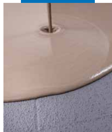
Påføring av Ultraplan selvutjevne avrettingsmasse over tørr Eco Prim Grip på gammel gulv
