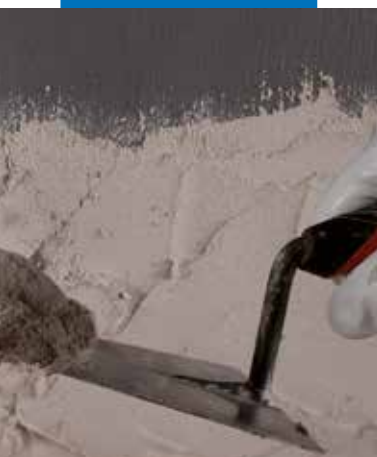
Påføring av puss over Eco Prim Grip
