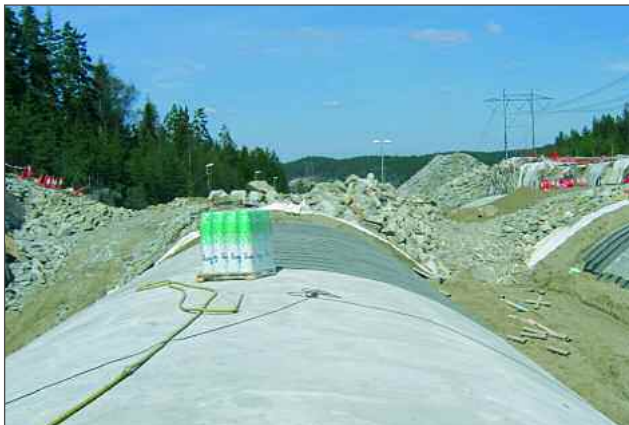
Betongbue, miljøtunnel, 4 felts motorvei
