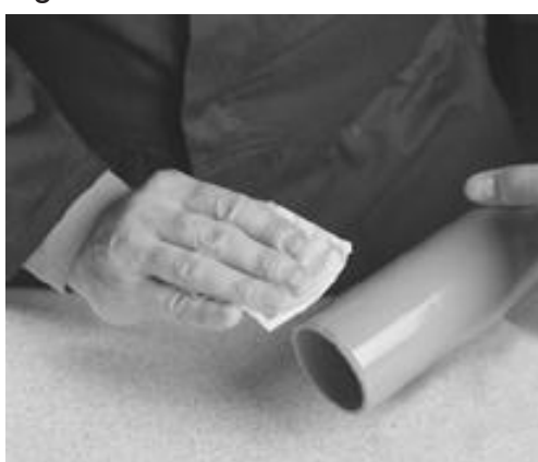
Rengjør rør og rørdel.
