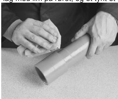
Tørk av overflødig lim.
