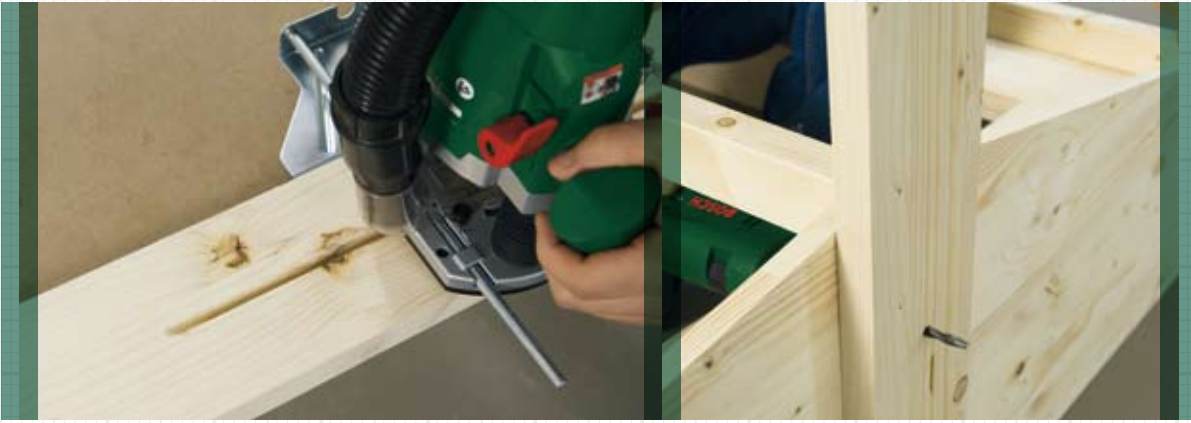
5. Klargjøre takstolper og montere dem på sandkassen
