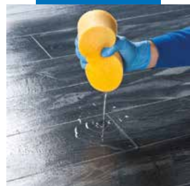
Overflaten av fugemassen fuktes godt for rengjøring
