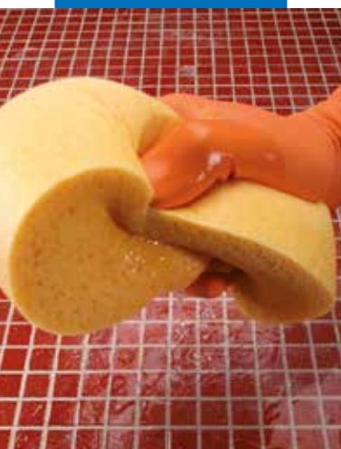
Overflaten av fugemassen fuktes godt før rengjøring
