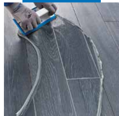
Påføring av Kerapoxy Design på treimittasjonsfliser utføres med et fugebrett i hard gummi
