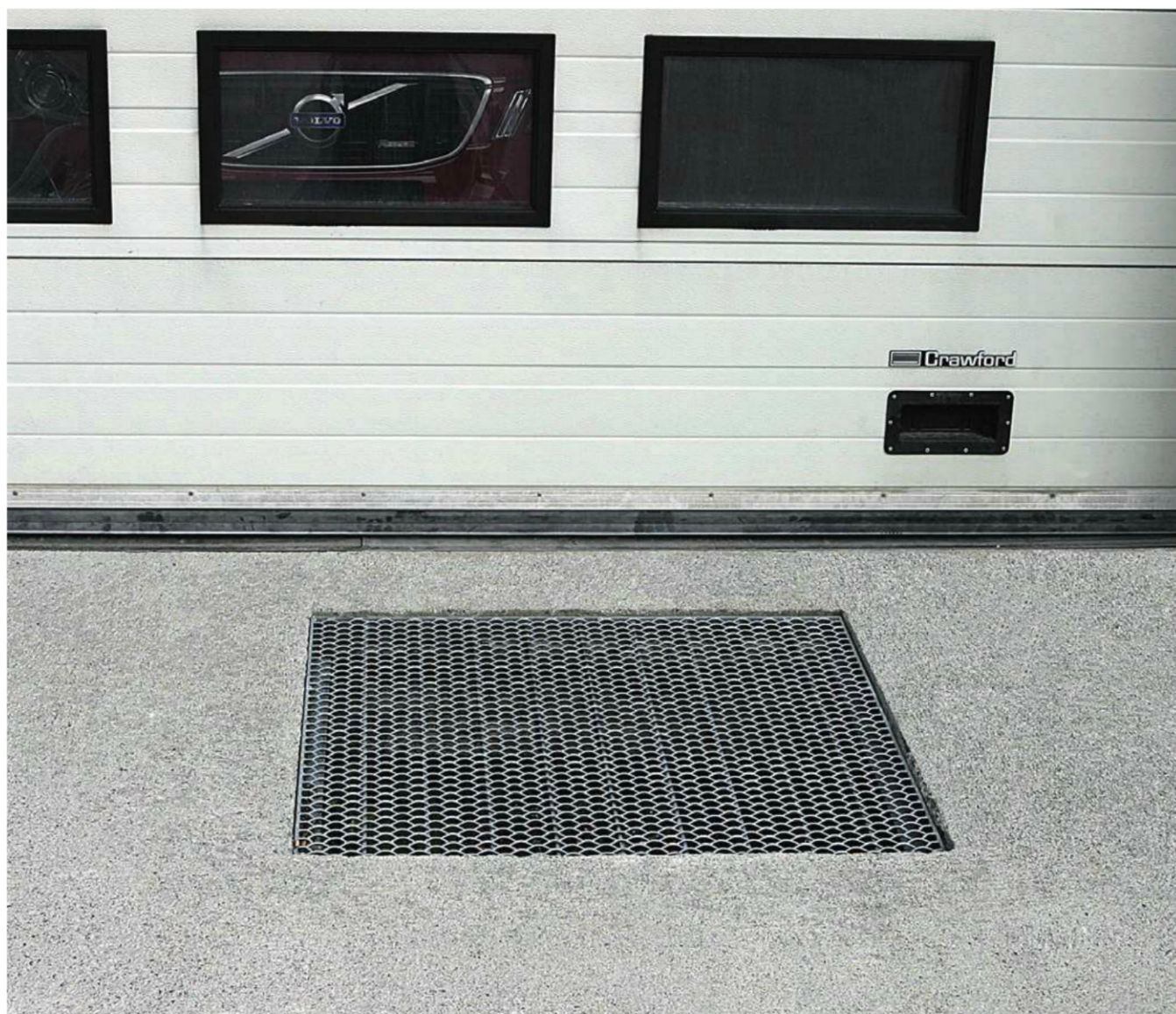
Kjøreforsterket rist foran garasje (bilforretning).
