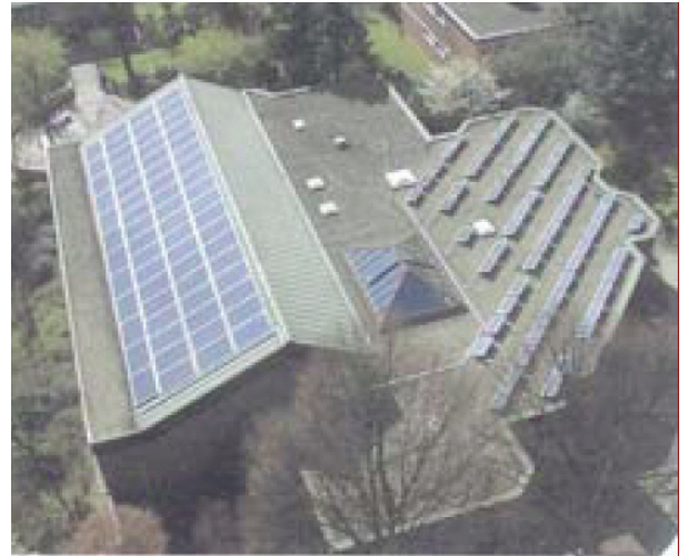
Fig. 8 a Eksempel på bygg der det er montert solcellepaneler på taket, både integrert i takflaten og montert oppå. Foto: Schonefeld [14]
