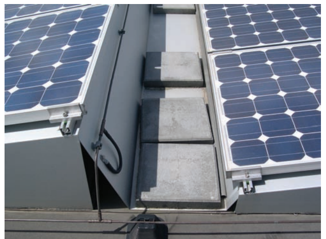
Fig. 8 f Nærbilde som viser eksempel på utforming av avskjermingen. Skjermingen er utformet slik at ballasten plasseres på den som vist. Foto: SINTEF Byggforsk
