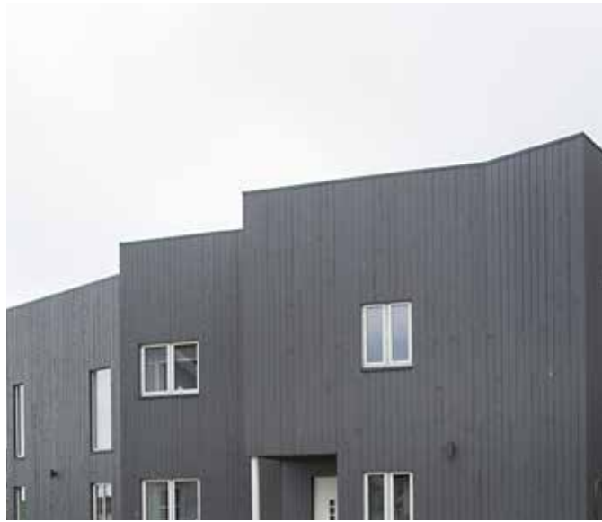
Udjusveien. Foto: Kaliber Foto
