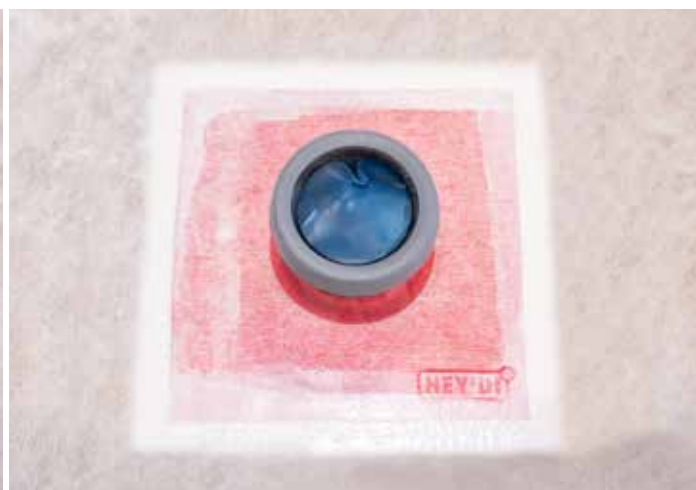
Husk det er viktig å stenge kantene på mansjetten med Hey'di Protac 25. Og slik skal en ferdig montert mansjett se ut.
