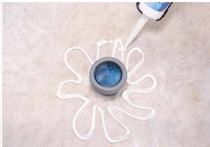
Påfør Hey'di Protac 25 runt rørgjennomføringen.
