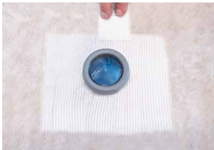
Spre ut Hey'di Protac 25 med egnet limspreder.
