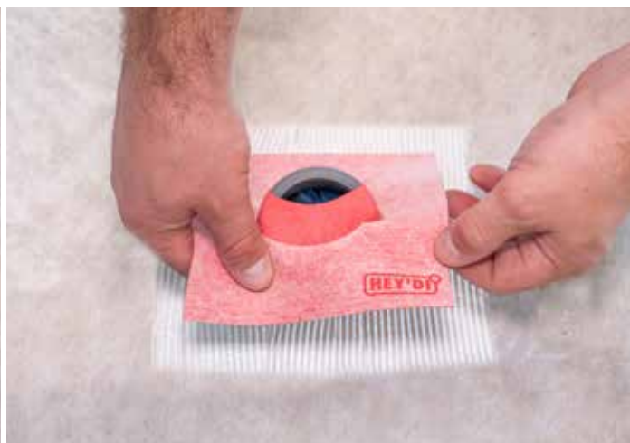
Monter tilpasset Hey'di RM rørmansjett
