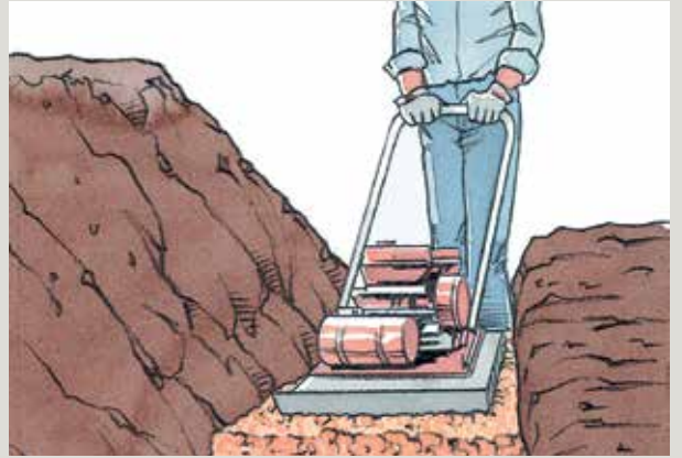
2 KOMPRIMERING AV AVRETTINGSLAGET (sålen)*
