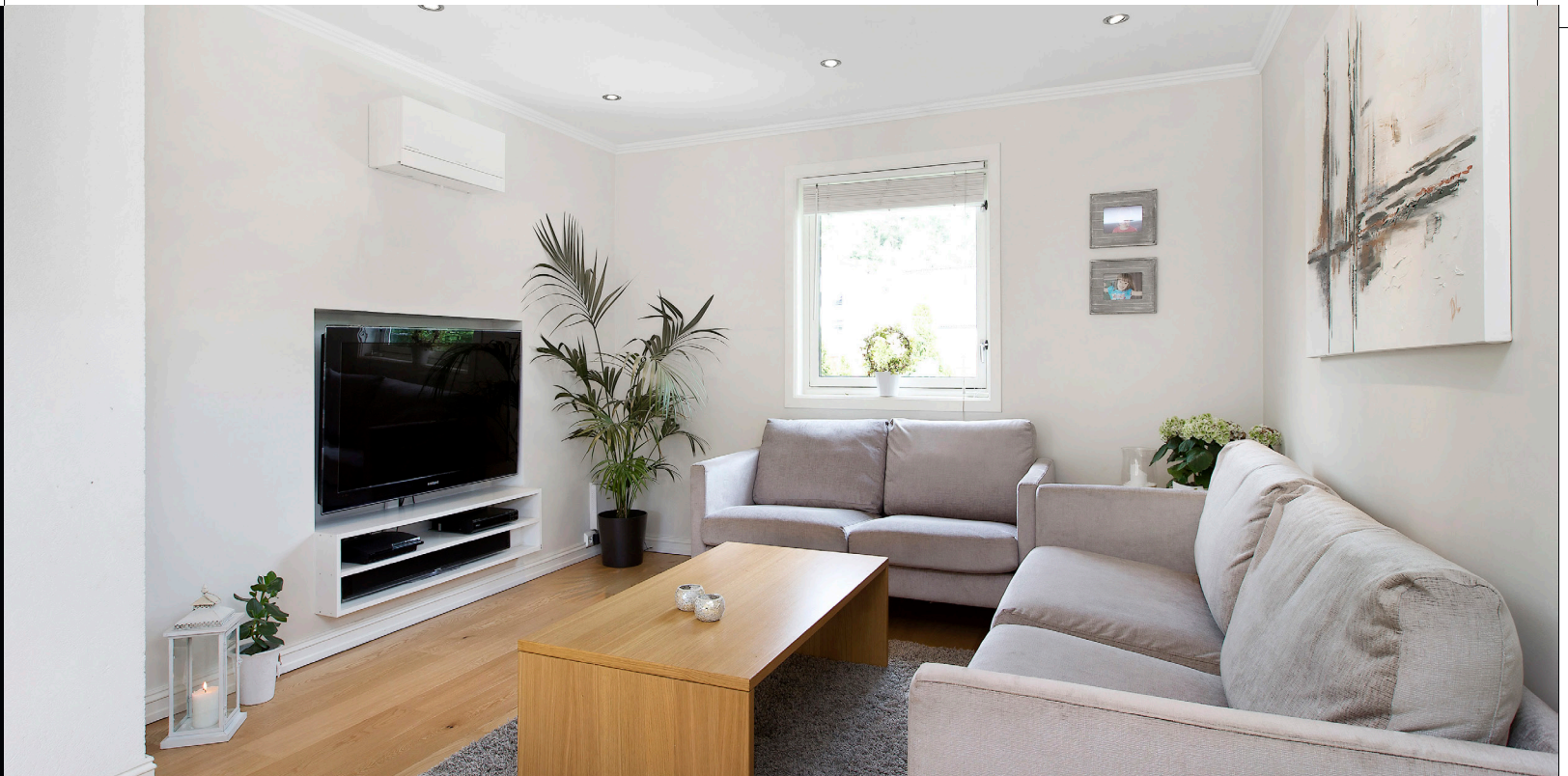
Miniventilasjon montert i stuen
