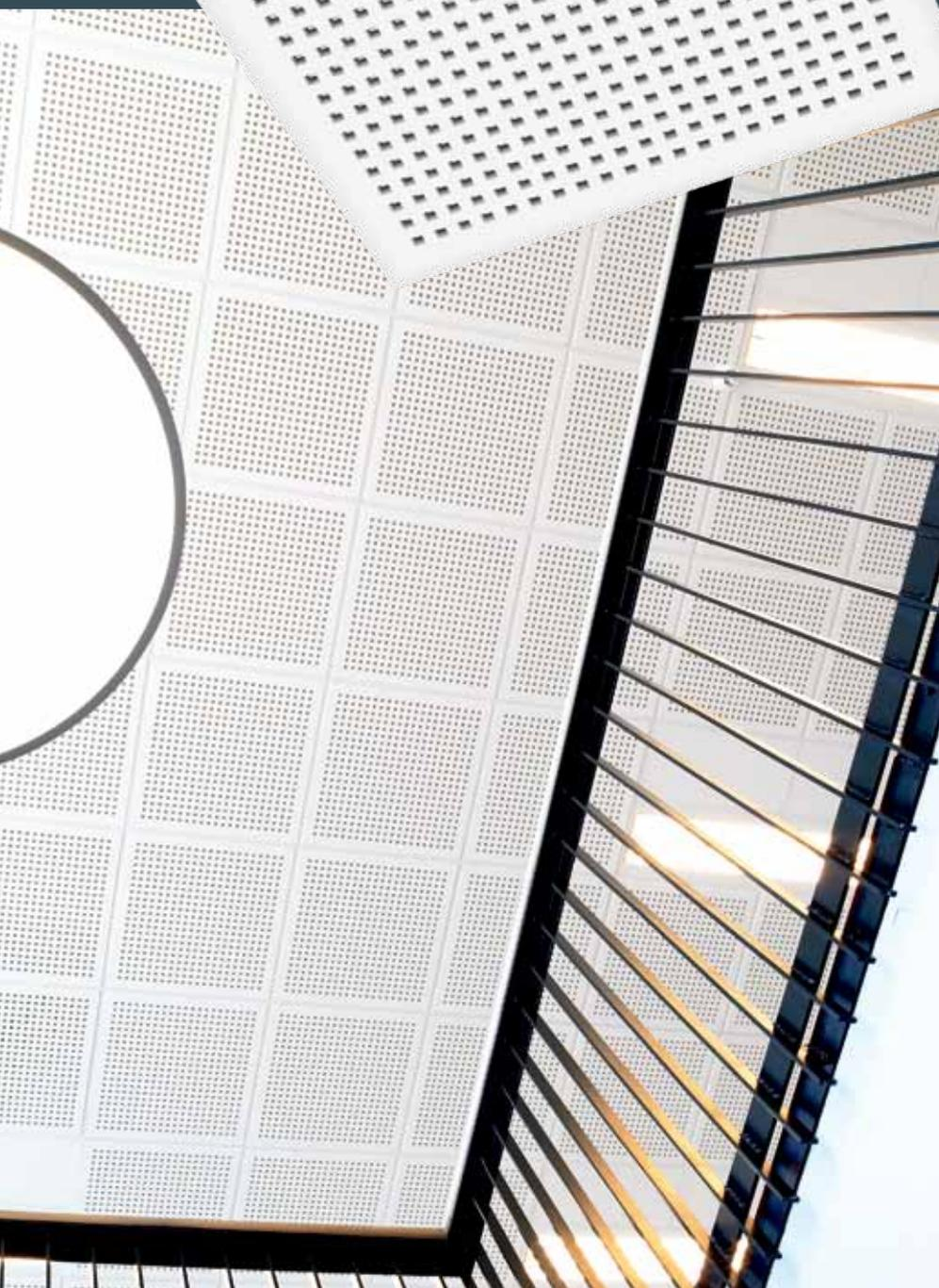
Produktprogrammet for Gyptone Quattro 50 omfatter ett standardmønster med kvadratiske hull. Platene framstilles med fire forskjellige kantutforminger tilpasset både synlige og skjulte opphengsystemer. Platene har gjennomgående hull som i kombinasjon med den bakenforliggende akustikkfilten, gir gode akustiske egenskaper.
