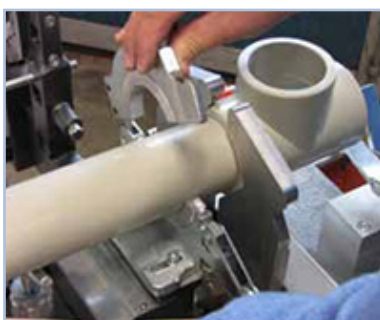
Monter røret i sveisemaskinen etter maskinens anvisninger.
