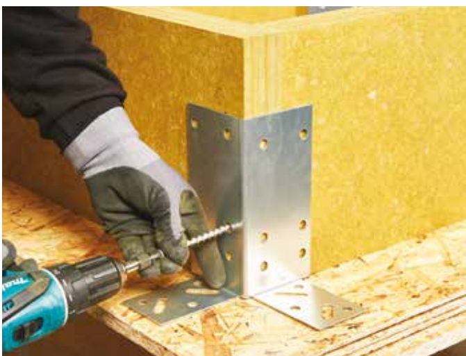
Montering av lang monteringskrue ved hjørnebeslag
