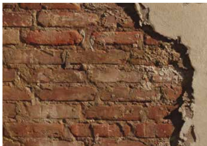
Eksempel på vegg som kun ved en stor innsats kan utbedres slik at kravene tilfredsstilles.
