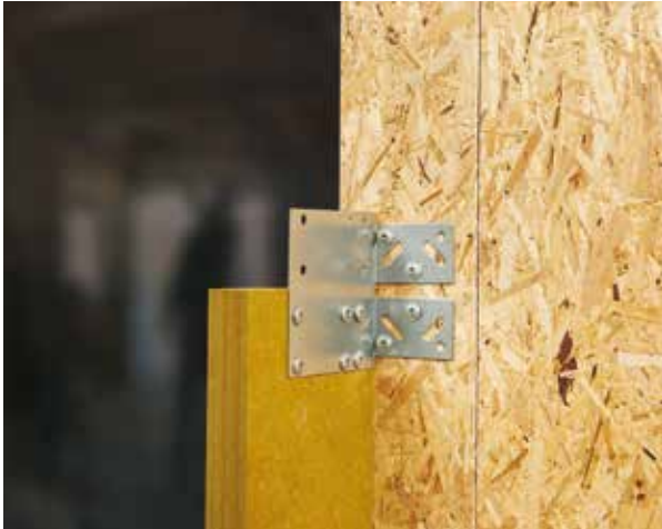
REDAir Link beslagene monteres på bakveggen
