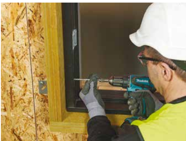
Montering av vindu i REDAir Link med lettbetongskruer
