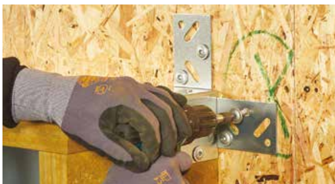
REDAir Link monteres på bakveggen med egnet skruer
