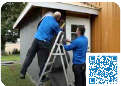
Montering av vindsperre
