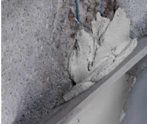
Utjevning av Planitop Smooth & Repair Zero med en rett kant
