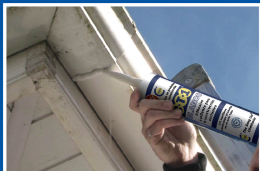
Reparerer umiddelbart takrenner som lekker
