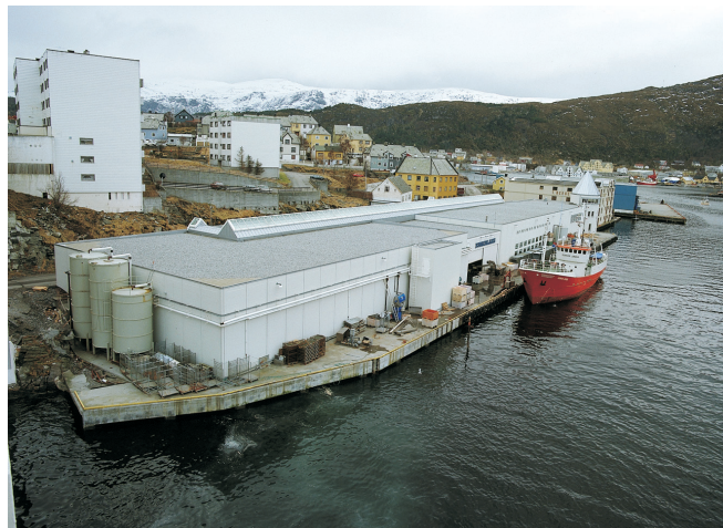
Kjøleinstallasjoner hos Fjordlaks AS
