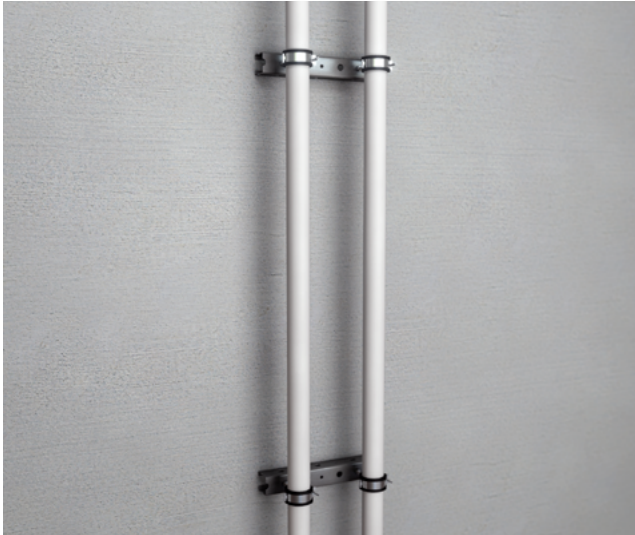
Eksempel på fiksering ved vertikal forlegning.
