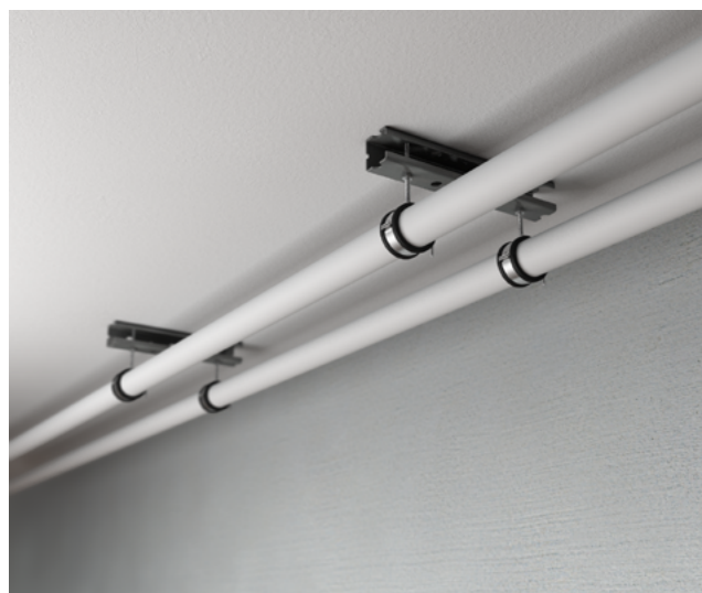
Eksempel på fiksering ved horisontal forlegning.
