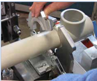
Monter røret i sveisemaskinen etter maskinens anvisninger.
