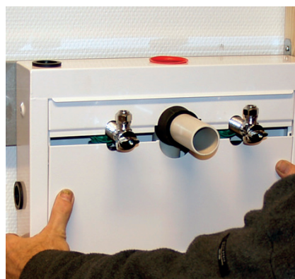
17. Nedre sprutplate slippes ned i skapet for så å løftes opp på fals i øvre plate. Sjekk gjennomføring.
