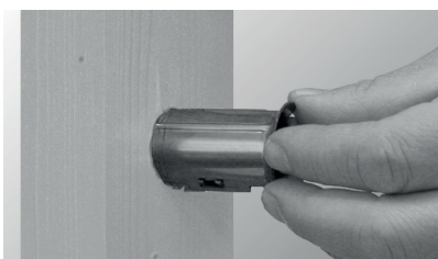
Skyv spikeravviseren inn i stender med kragen mot tappestedet.
