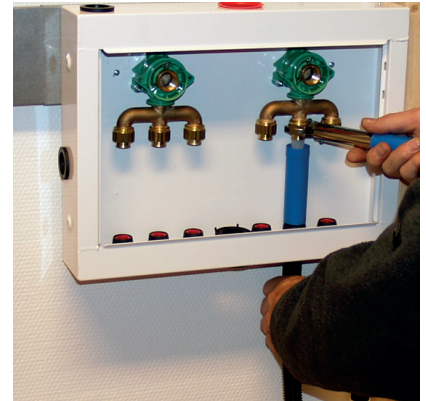
12. Entre kplung for hånd og trekk til med momentnøkkel.
