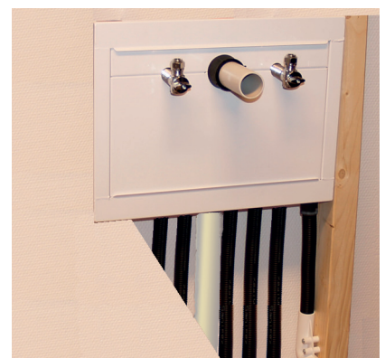
18. Riktig montert skal fronten flukte med ferdig vegg.
