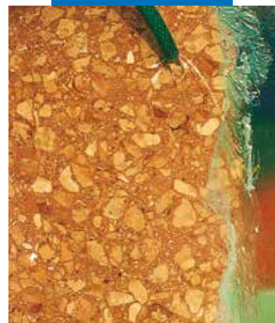
Rengjøring av naturstein med rennende vann
