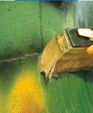
Påføring av WallGard Graffiti Remover Gel med kost
