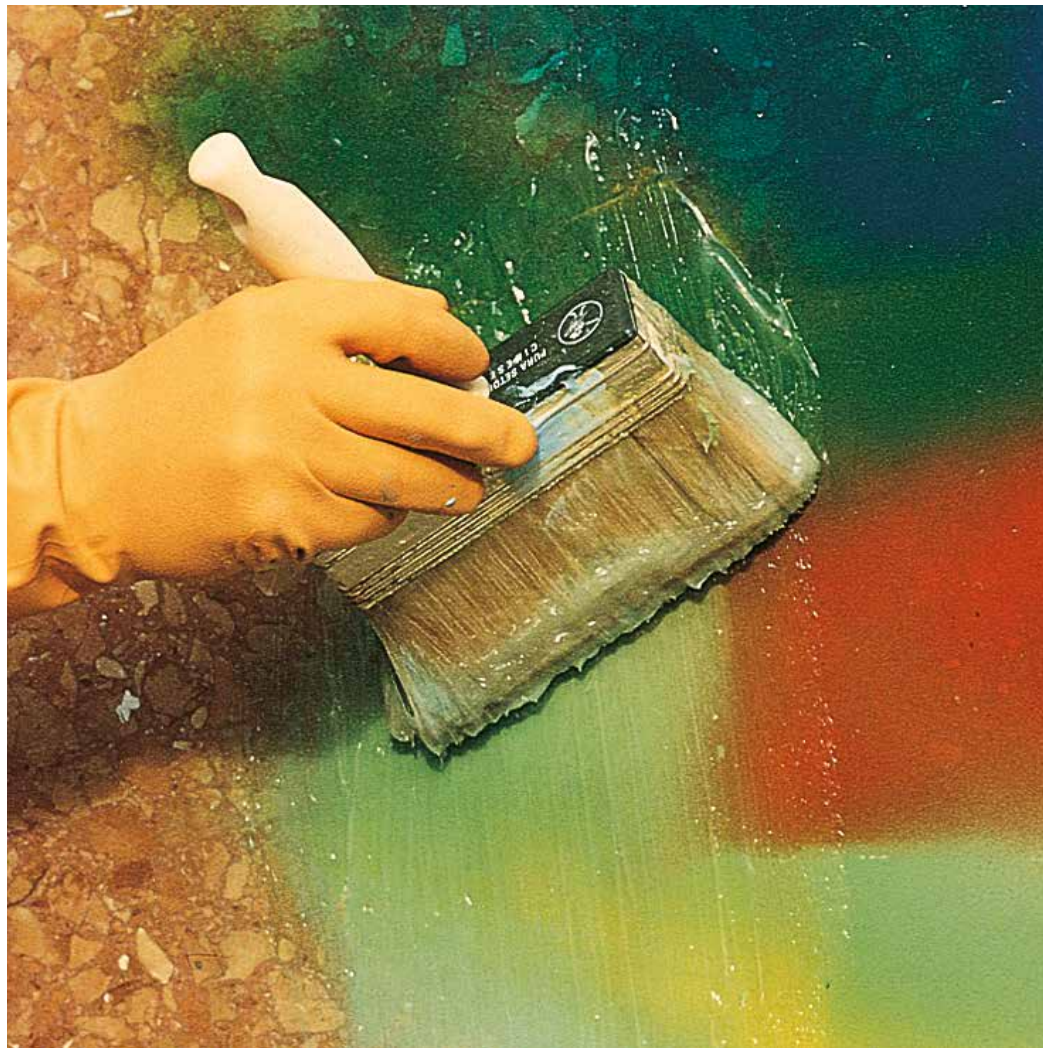
Påføring av WallGard Graffiti Remover Gel med kost
