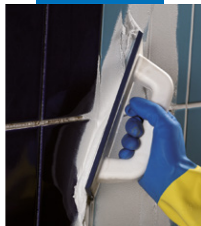
Fordeling av Kerapoxy CQ på vegg med MAPEI pussebrett
