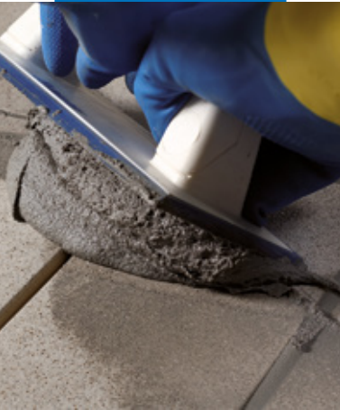
Fordeling av Kerapoxy CQ med Mapei fugebrett
