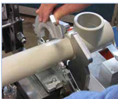
Monter røret i sveisemaskinen etter maskinens anvisninger.
