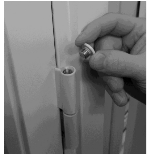
Fig 21. Demontering av dekklokk på toppen av hengsler.
