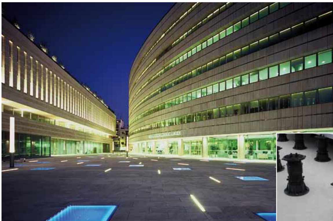
Terrasse på sokler med steineheller som toppdekke
