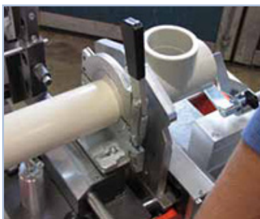
Lim sammen rør og muff.
