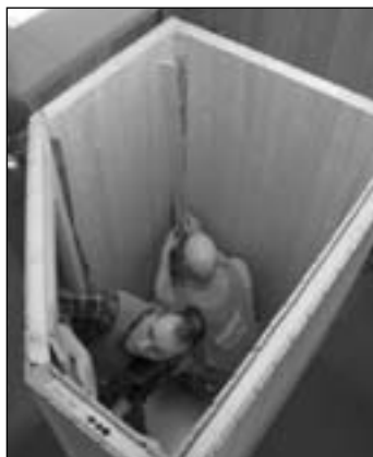
Kuva 4. Viimeinen liitos saunan nurkassa Bild 4. Den sista fogen i bastuns hörn
