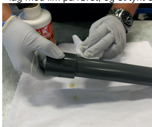
Tørk av overflødig lim.
