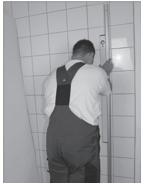
Mål opp plass til monteringen i tråd med anvisningene for dusjveggen. Press deretter fast profilen mot veggjen og kontroller at den er i vater.
