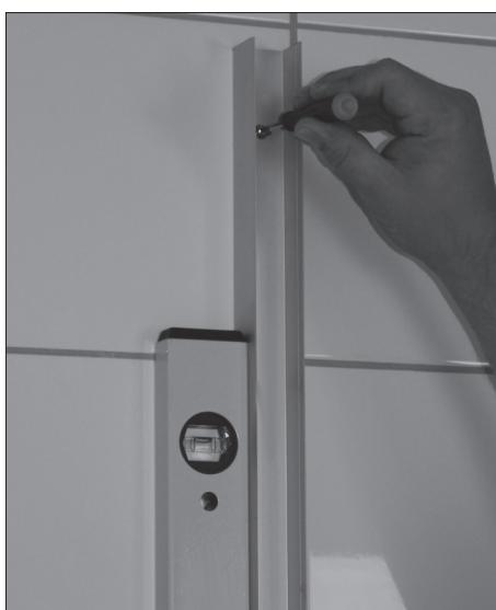
Lav skivene med lim herde i 24 timer i normal romtemperatur. Monter deretter profilen mot veggskivene igjen, og fest den med mutrene. **Tips!** Bruk 7 mm pipeskrutrekker for å komme til i profilen når du skal låse mutrene i skiven.
