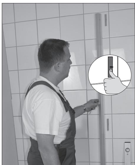
Lossa muttrarna och tag lossa åter profilen försiktigt från väggen. Det är viktigt att kontrollera att väggbrickorna sitter dikt an vägg. Tryck ordentligt! Efterkontrollera att hålbilden i profilen matchar brickornas läge. Justera vid behov.
