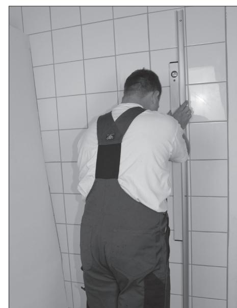
Mätta ut plats för montage enligt duschkäggenas anvisningar. Tryck därefter fast profilen mot väggen samt kontrollera att profilen sitter i lod.
