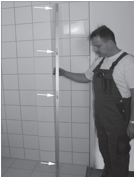
Fordel de fire veggskivene over profilen, legg dem i skruehullene og fest dem løst med mutrene. Følg limprosessen for påføring av lim og rengjøring.
