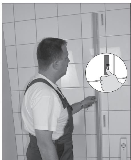
Løsne mutrene, og løsne profilen forsiktig fra veggjen. Det er viktig å kontrollere at vegg-skivene ligger an mot veggen. Press godt! Kontroller at hullbildet i profilen stemmer med skivenes posisjon. Juster ved behov.
