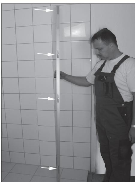
Fördela de fyra väggbrickorna över profilen, lägg dem i skruvhålen och spän fast dem löst med muttrarna. Följ limprocessen för applicering lim & rengöring.
