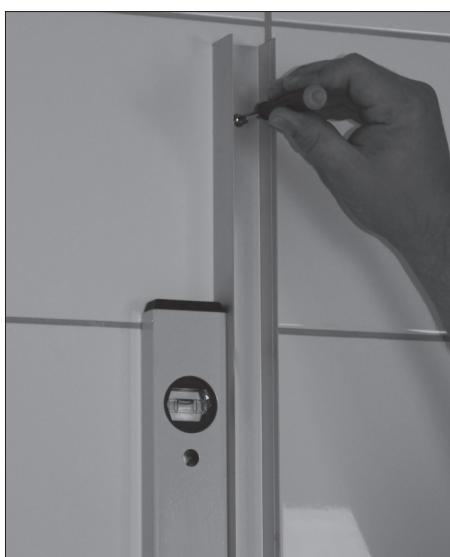
Låt brickorna med lim härla 24h i normal rumstemperatur. Montera därefter fast profilen mot väggbrickorna igen och lås med muttrarna. **Tips!** Använd 7 mm hylsmejsel för enkel åtkomst i profilen för att låsa muttrarna i brickan.
