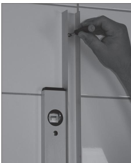
Anna liimattujen aluslevyjen kovettua 24 tuntia normaalissa huonelämpötilassa. Asenna sitten profiili uudelleen seinälevyjä vasten ja kiristä mutterit. **Vinkki!** Käytä 7 mm hylsyntaltaa, jonka avulla pääset helposti kiinnittämään mutterit.
