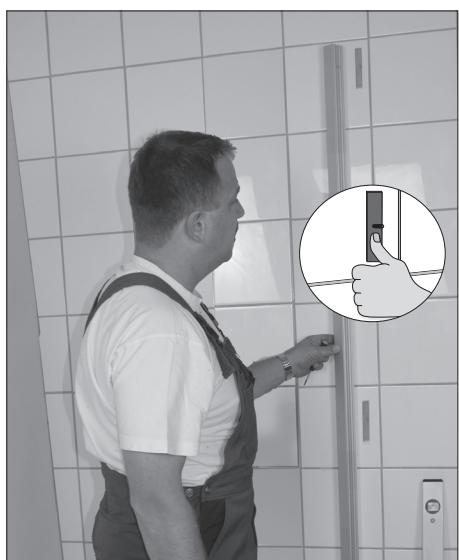
Löysää mutterit ja irrota profiili varovasti seinästä. On tärkeää tarkistaa, että seinälevyt ovat tiiviisti seinää vasten. Paina hyvin! Tarkista, että profiiliin reiät vastaavat aluslevyjen sijaintia. Säädä tarvittaessa.
