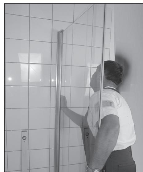
Asenna seuraavaksi suihkuseinä seinä-profiiliin, säädä ja kiinnitä lasi suihkuseinän ohjeiden mukaisesti. VALMIS!
