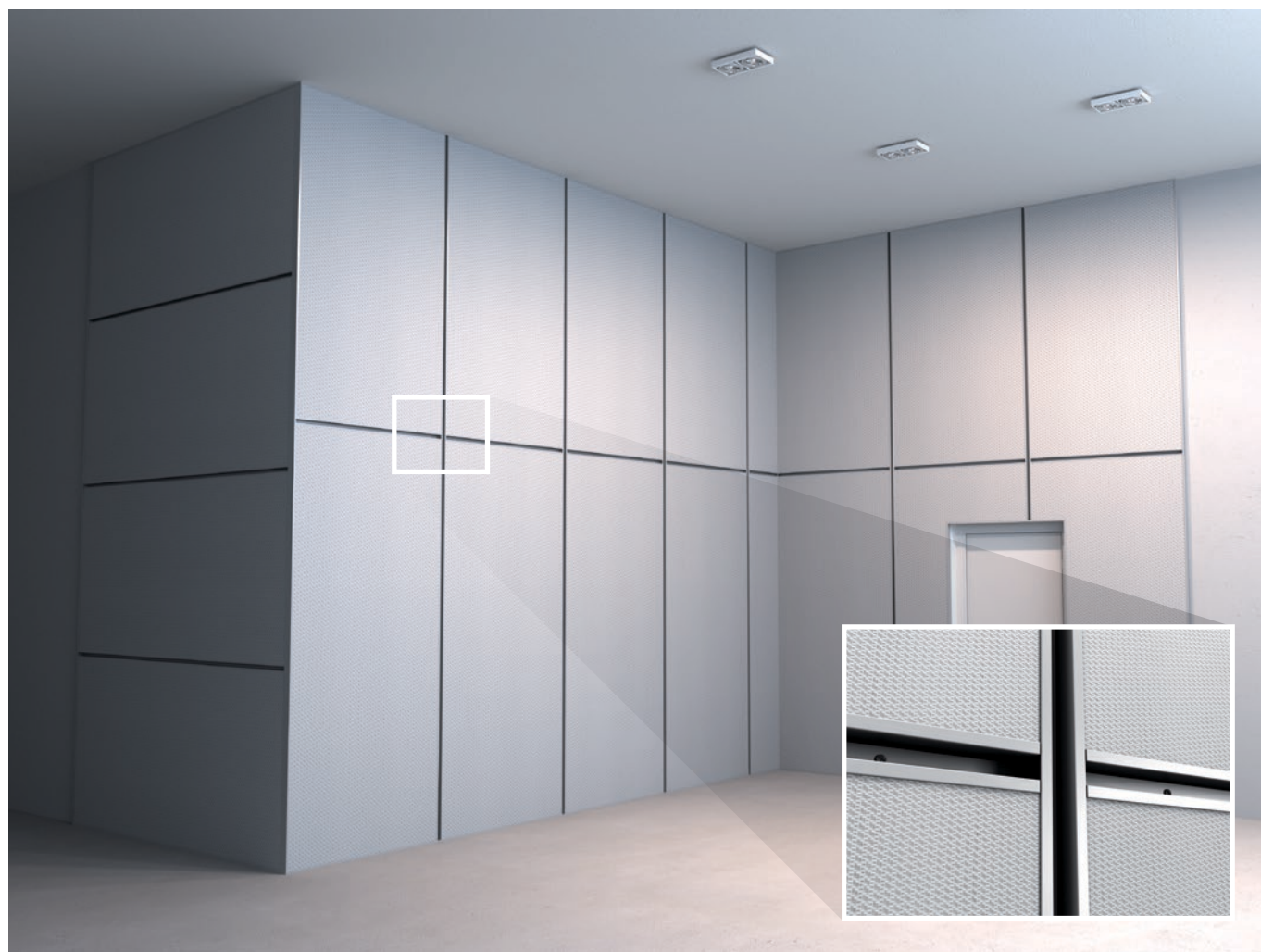
3.1 Alle Rockfon VertiQ veggabsorbenter og HAT-profiler installert.
