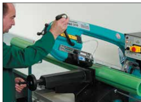
Kapp 160 mm røret i riktig lengde før sveisingen
