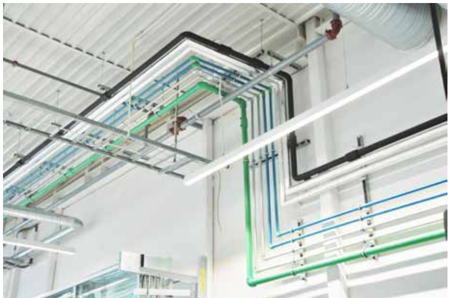
Aquatherm blue pipe-rør
