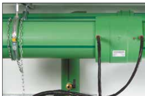
Still sveisemaskinen på riktig dimensjon. Start sveisingen og overvåk hele prosessen. Overhold avkjølingstiden.
