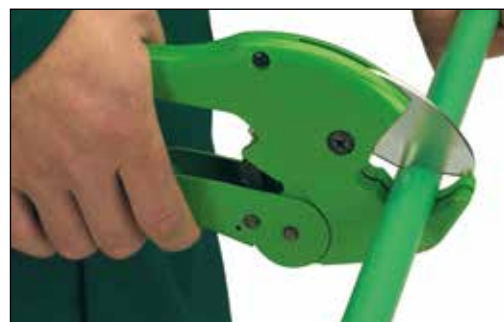
Kapping av røret
