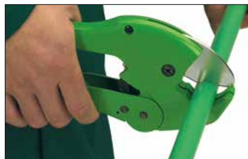
Kapping av røret
