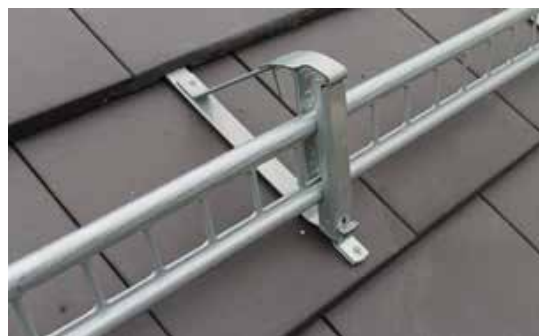
Bilde 2: Montering av snøfanger
