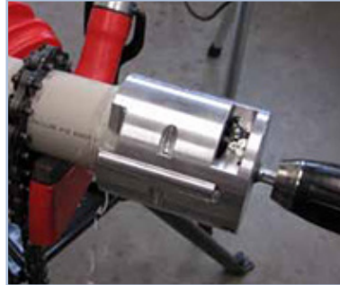
Skrap utsiden av røret.
