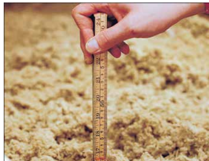
5. Samtidig som løsullen blåses utover kontrollerer man nivået. Som regel anbefales det mellom 300 - 500 mm løsull på loftet.
