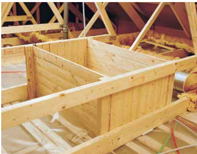
1. Rundt loftsluken monteres det en krage for å forhindre løsull å falle ned når luken åpnes.
