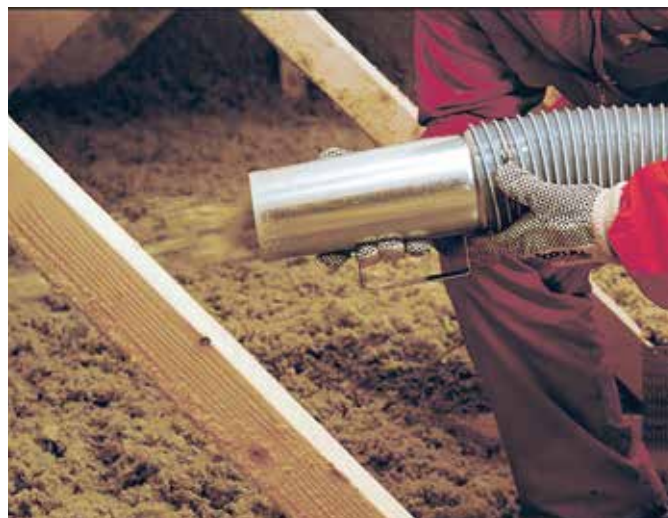
4. Den andre blåser ullen jevnt ut over bjelkelaget på loftet. Slangen skal holdes horisontalt, ca 1 meter over bjelkelaget.
