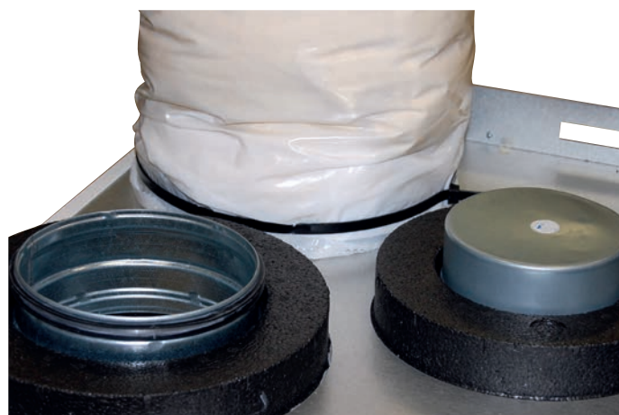
Figur 21 Ferdig montert kanal
