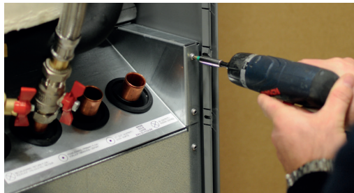
3. Avlägsna kylmodulens fästskruvar.
