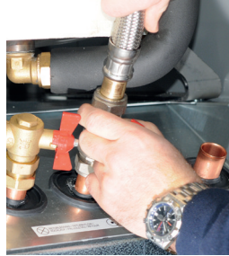
1. Lossa kylmodulens elkabelkontakt och slangar.
