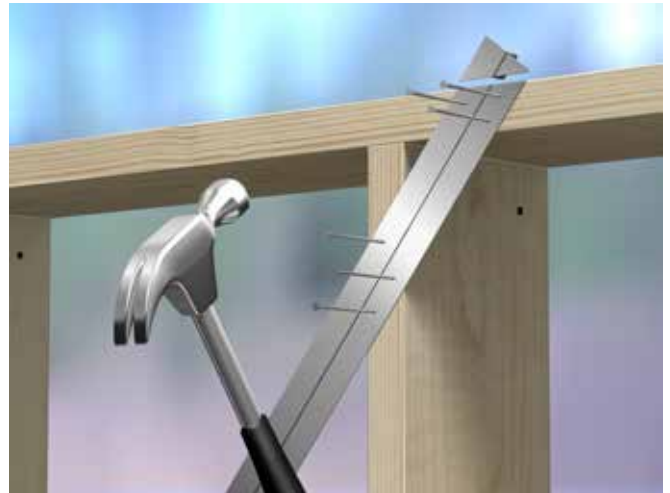
Fig. 32 Spikring av avstivningsstag
