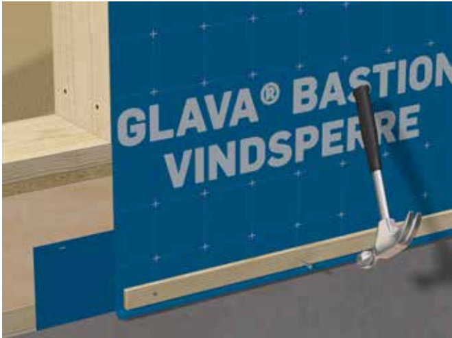
Fig. 36 Klemming av vindsperre mot grunnmursvill
