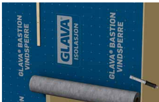
Fig. 35 Vertikal montering av vindsperre
