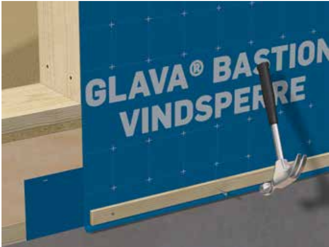
Fig. 36 Klemming av vindsperre mot grunnmursvill
