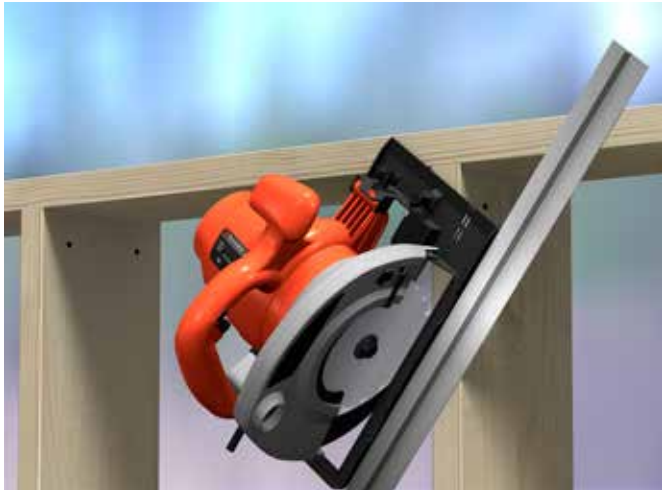
Fig. 30 Slissing i stenderverk for avstivningsstag
