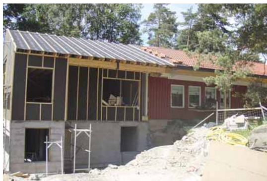
Tilbygget til Son Naturbarnehage begynner å ta form. Hunton Vindtett sørger for at bygget er tett.
