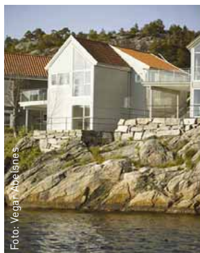
Hytter fra prosjektet Furuholmen har benyttet Hunton Vindtett 12mm.
