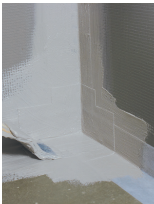
Hjørnemansjett monteres vått-i-vått. Selvklebende bånd dekkes med membran.
