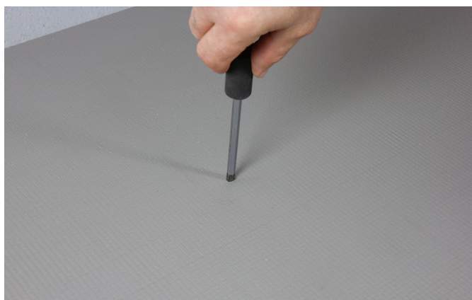
Lag hull til senter av limpunktene.
