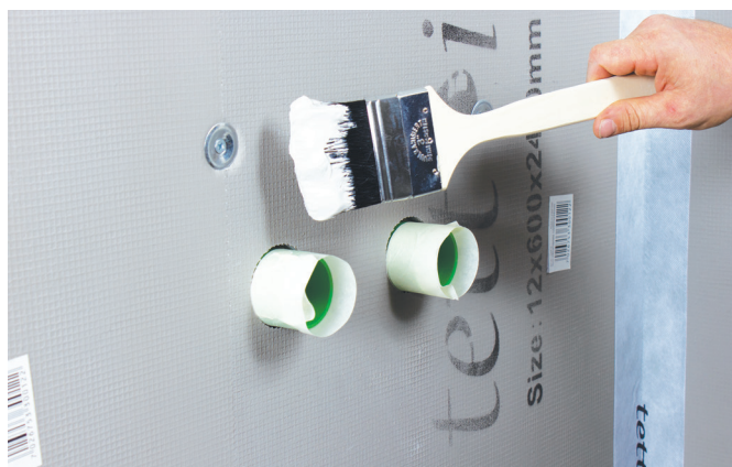
Påfør membran i et tilstrekkelig stort område.
