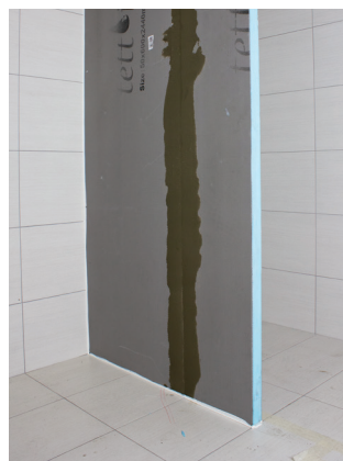
Dusjvegg klar for flislegging.
