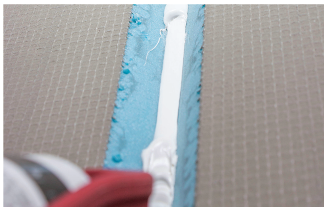
Påfør lim i rørkassens v-spor.
