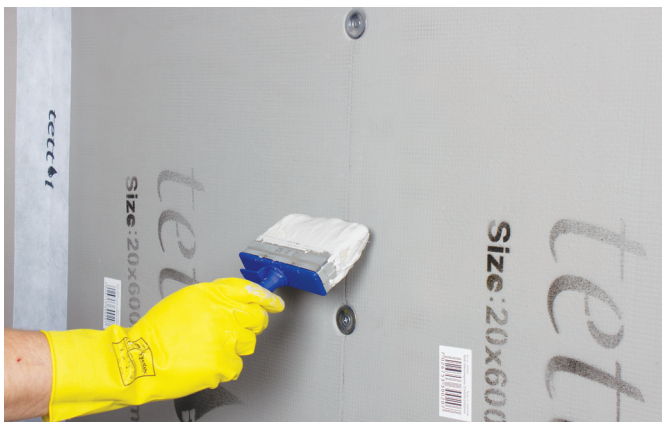
Påfør membran på hver side av plateskjøt.
