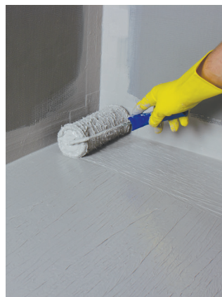
Påfør membran langs veggene med pensel. Malerulle benyttes gjerne på hele gulvet.
