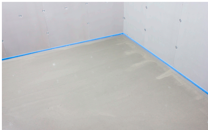
Ferdig avrettet gulv.
