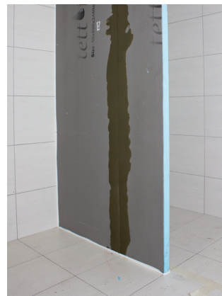
Dusjvegg klar for flislegging.
