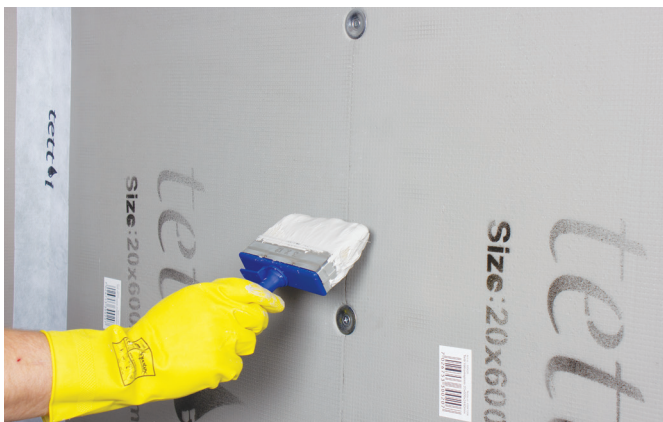
Påfør membran på hver side av plateskjøt.
