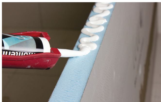
Påfør tilstrekkelig med Tetti monteringslim.
