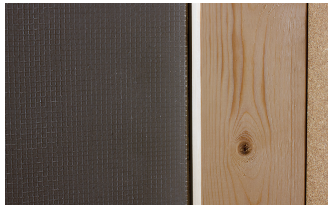
Monter med et par mm. klaring til vegg.
