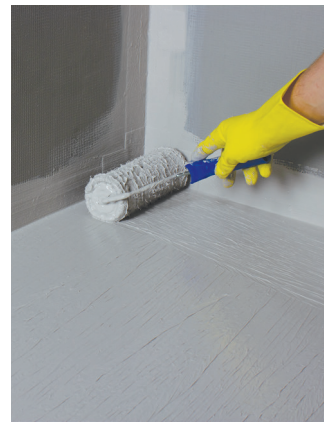
Påfør membran langs veggene med pensel. Malerulle benyttes gjerne på hele gulvet.
