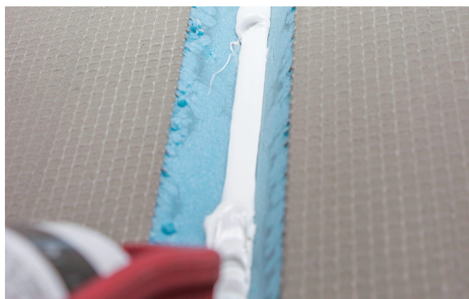
Påfør lim i rørkassens v-spor.
