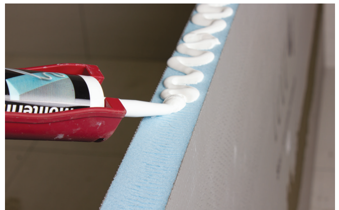
Påfør tilstrekkelig med Tetti monteringslim.
