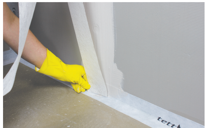
Legg fiberremsen i våt membran.
