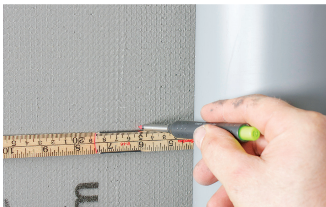
Ta mål og tilpass rørkassen i høyde.
