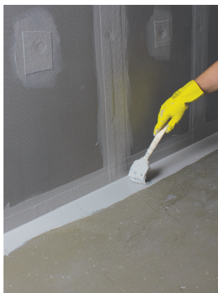
Påfør membran langs veggene med pensel. Malerulle benyttes gjerne på hele gulvet.
