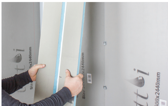
Sett kassens sidevegger i rett vinkel.
