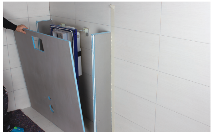
Påfør monteringslim på ramme, vegg og gulv.
