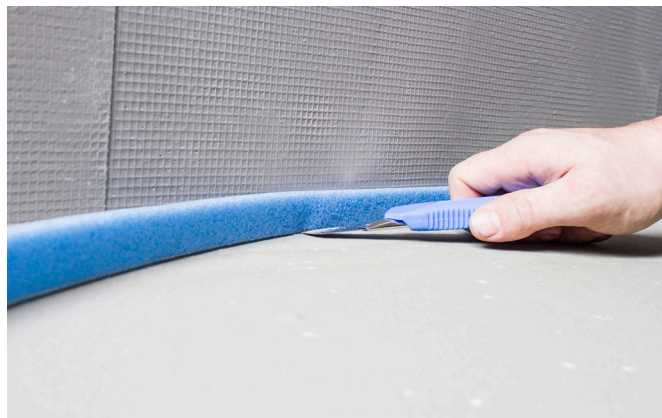
Overskytende ekspansjonsbånd fjernes.
