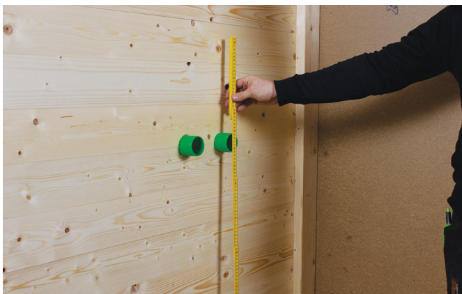
Ta alle nødvendige mål før utskjæring.
