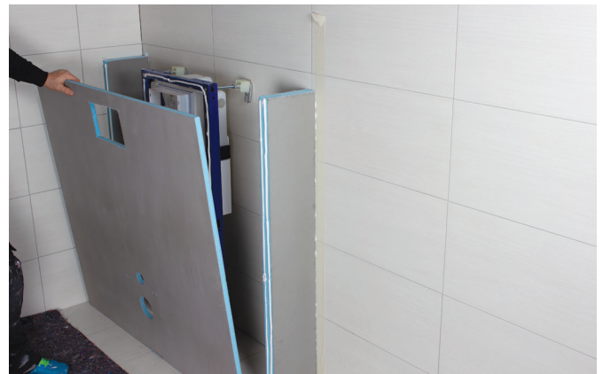
Påfør monteringslim på ramme, vegg og gulv.
