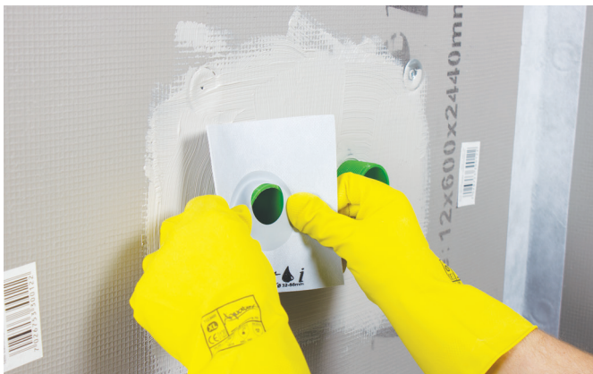
Tre mansjetteen forsiktig på røret.
