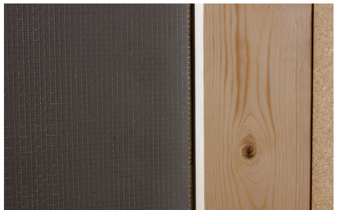
Monter med et par mm. klaring til vegg.
