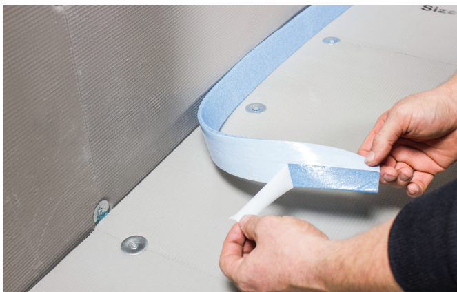
Benytt ekspansjonsbånd langs alle vegger.
