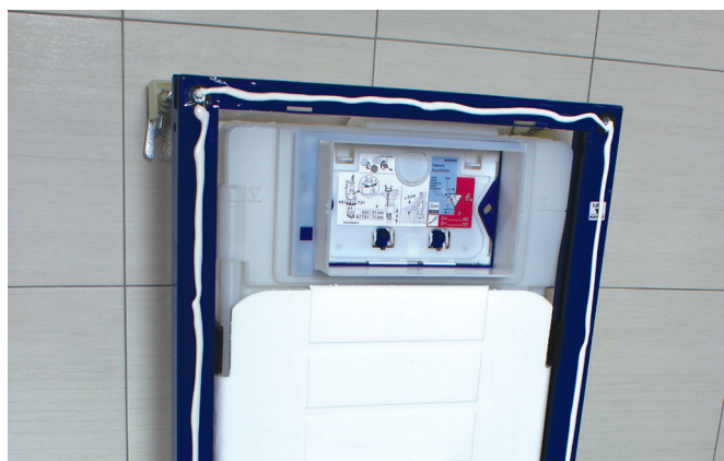
Påfør monteringslim på ramme, vegg og gulv.
