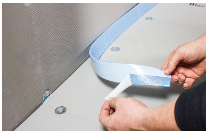
Benytt ekspansjonsbånd langs alle vegger.
