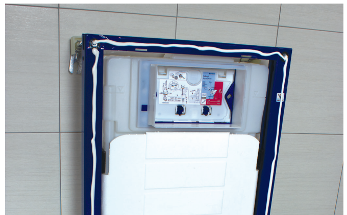
Påfør monteringslim på ramme, vegg og gulv.
