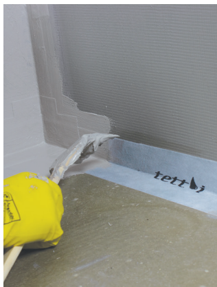
Hjørnemansjett monteres vått-i-vått. Selvklebende bånd dekkes med membran.
