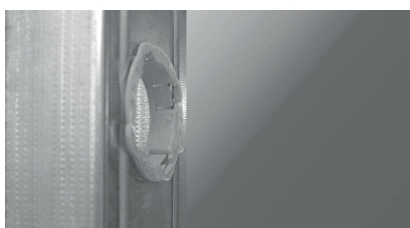
1. Lag et 35mm hull med f.eks. en hullstans. Sett inn plastforing.
