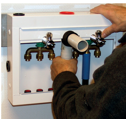
16. Sett inn øvre del av sprutplate og påse at gjennomføring for avløp stemmer med utsparring i plate.
