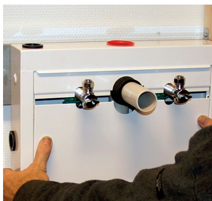
17. Nedre sprutplate slippes ned i skapet for så å løftes opp på fals i øvre plate. Sjekk gjennomføring.
