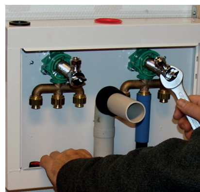
15. Tilpass og monter vinkelventiler i veggbokser. Plugg ubenyttede uttak.
