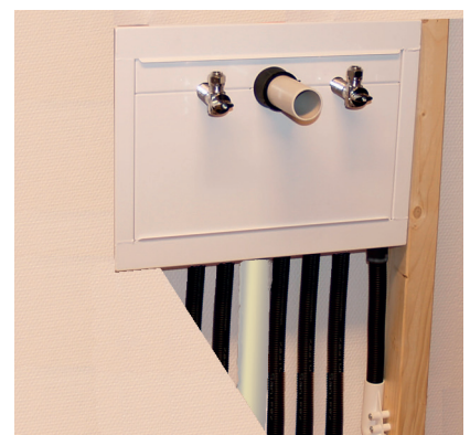
18. Riktig montert skal fronten flukte med ferdig vegg.
