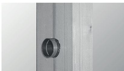
Påse at spikeravviserens skjøter står vertikalt og går igjennom stender så spor for fikseringsklammer er synlig.
