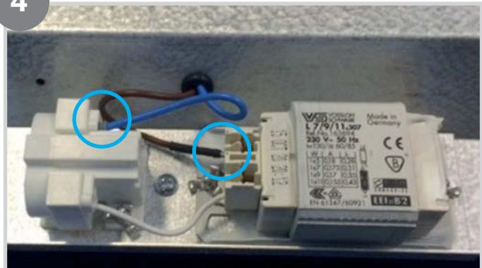
**SV** Med det här kit'et uppdateras ljuskällan i din K2 från kompaktlysrör (med elektromagnetiskballast) till LED-ljuskälla utan ballast.
